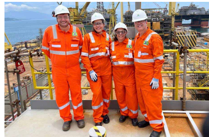
Equipe da PPSA em visita aos módulos da P-78 no estaleiro BrasFELS
